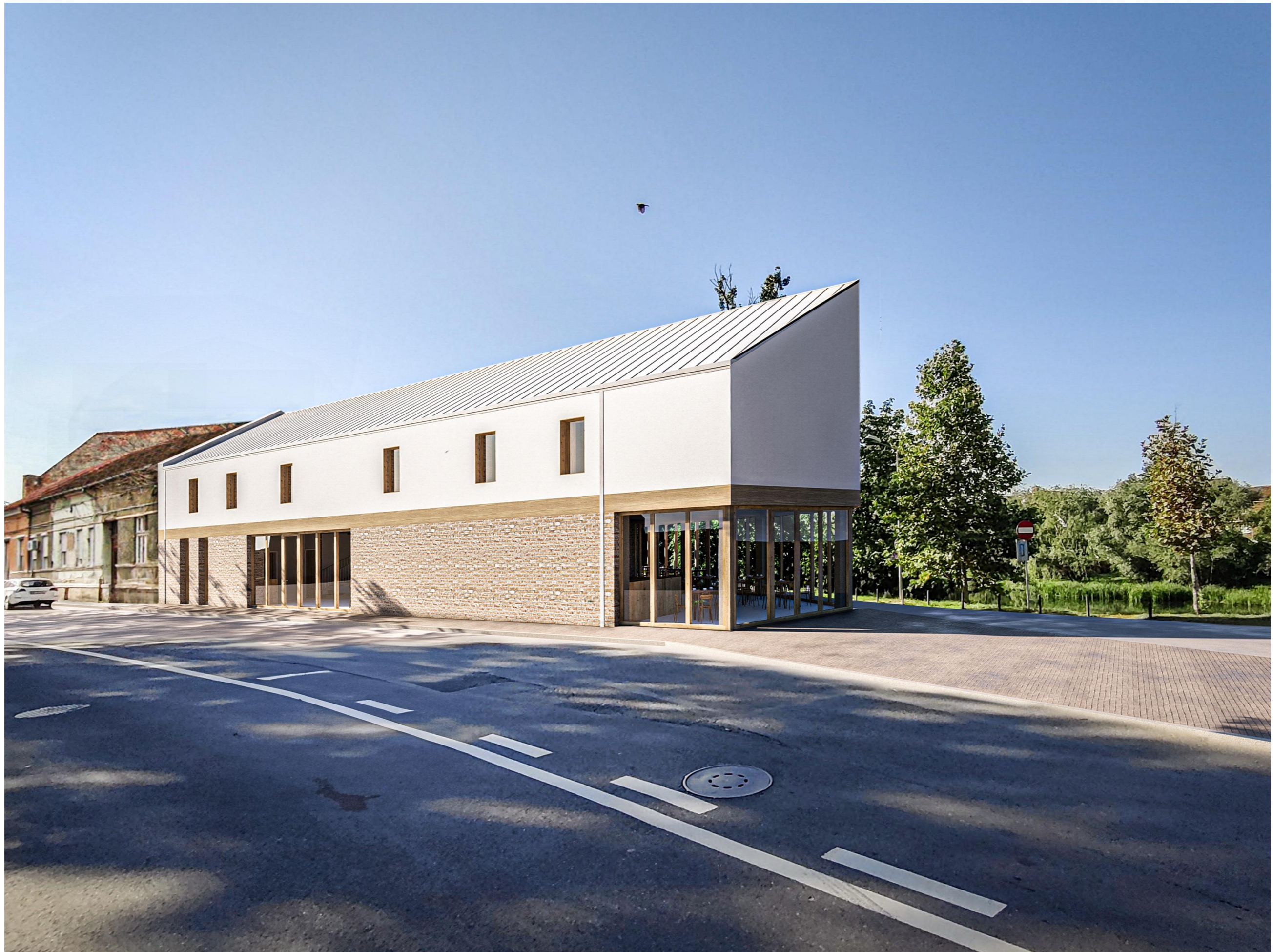
Kerékpáros pihenő és szállás // Nagyvárád Sárközi Alexander Konzulens: Bartha András Márk DLA BSC Diplomatervezés // BME Középülettervezési Tanszék
