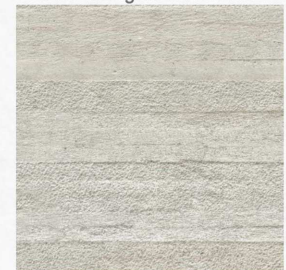
külső döngölt beton fal
