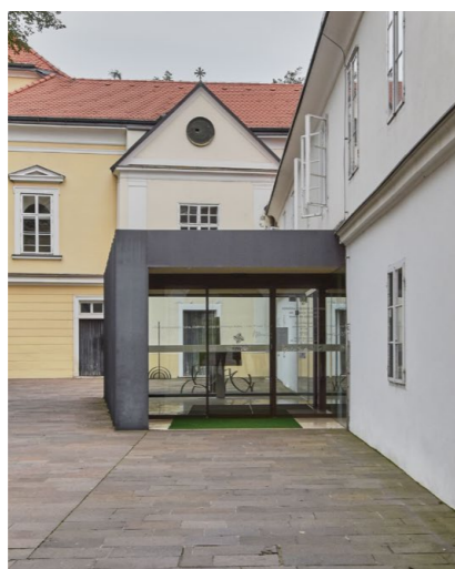
076 ▪ Acélszerkezetű bejárati előtér
