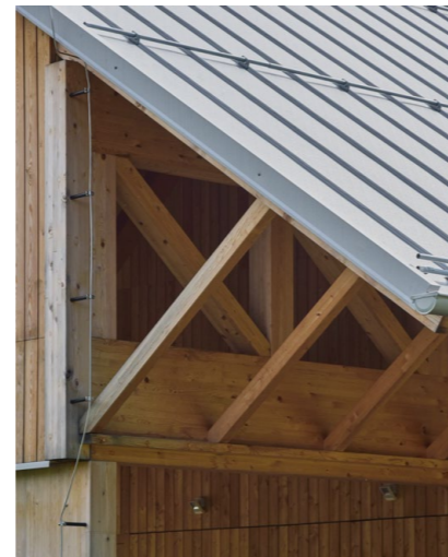
042 • A bohinji óvoda tetőszerkezete
