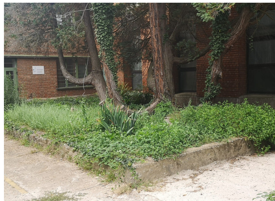
Az épületek között meglévő kis udvarok
