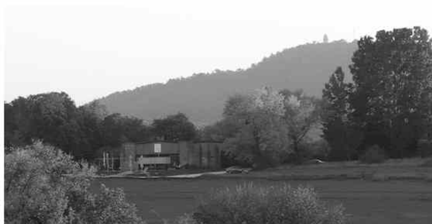
A hangár a szemközti domboldalról, saját fénykép
