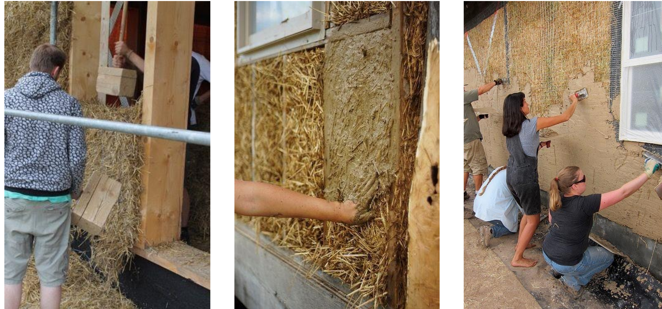
Szalmabála fal építése (illusztráció, forrás: strawbale.com)
