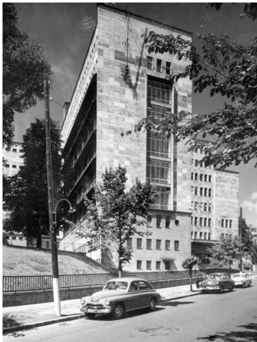
OTBA Kórház_Budapest Kútvölgyi út 4. Csánk (Rottmann) Elemér 1942-44
