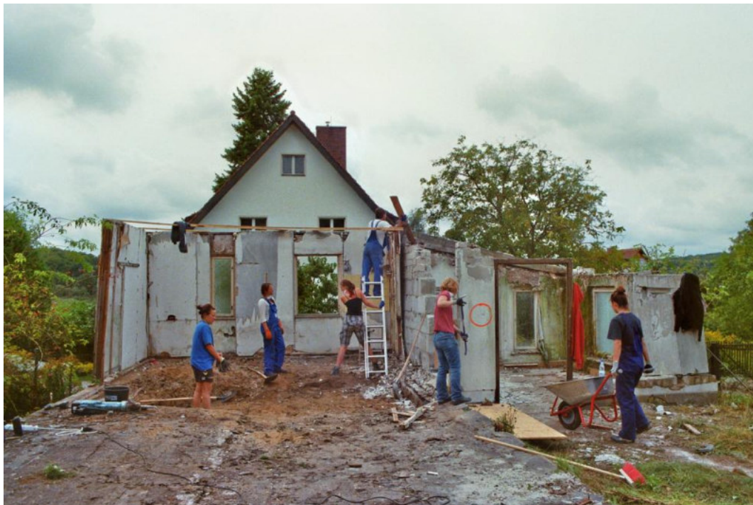
(( Brandlhuber // Rachel, építés közben. Fotó: Brandlhuber ))
