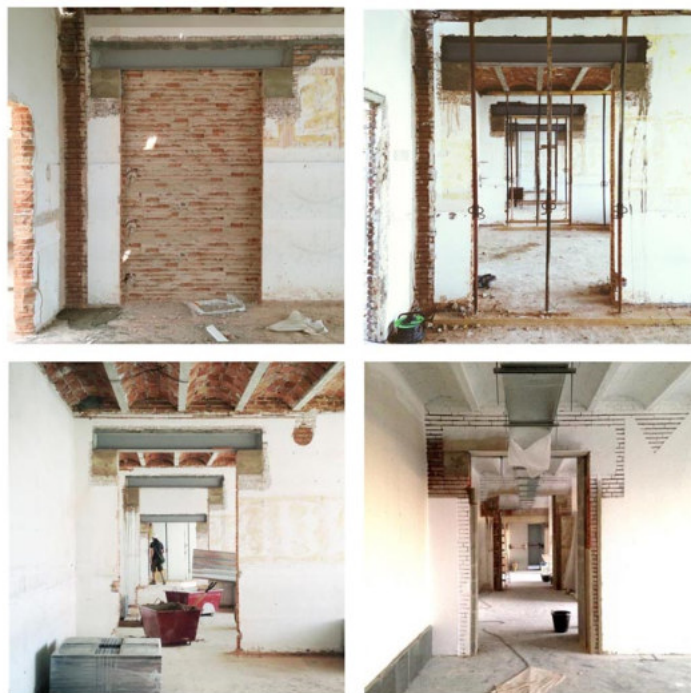
(( Harquitectes // Reforma de l'Escola 906, átalakítás közben. Fotók: Harquitectes ))
