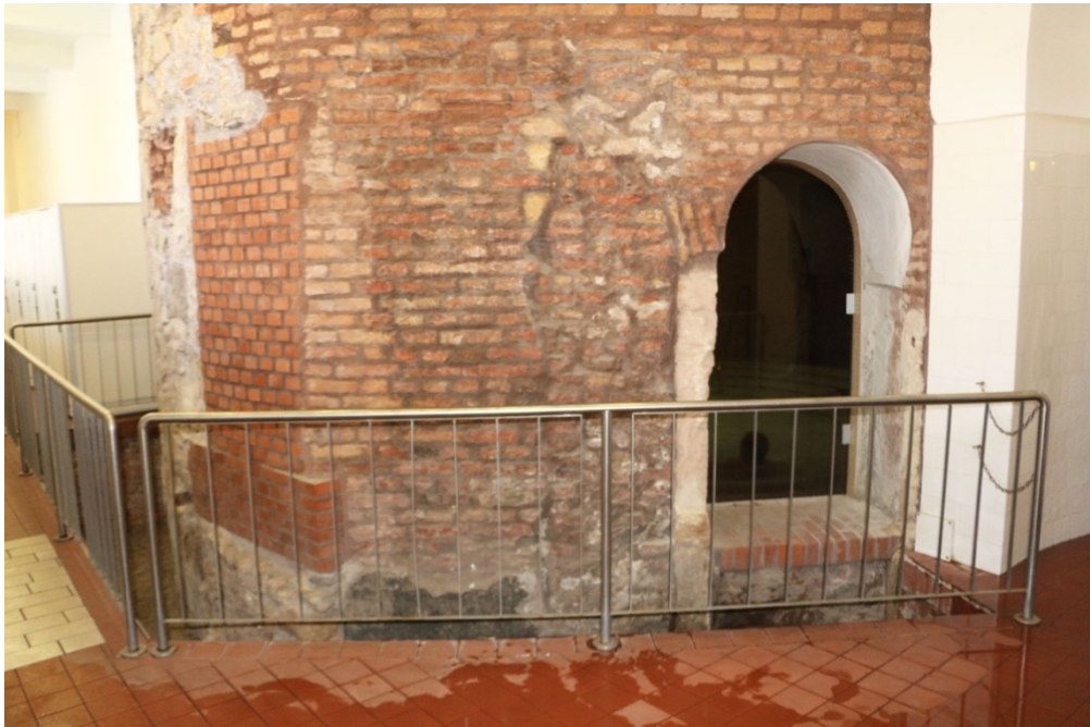
72. A termálfürdő megmaradt, helyreállított törökkori falszakasza üvegezett nyílással a medence felé
