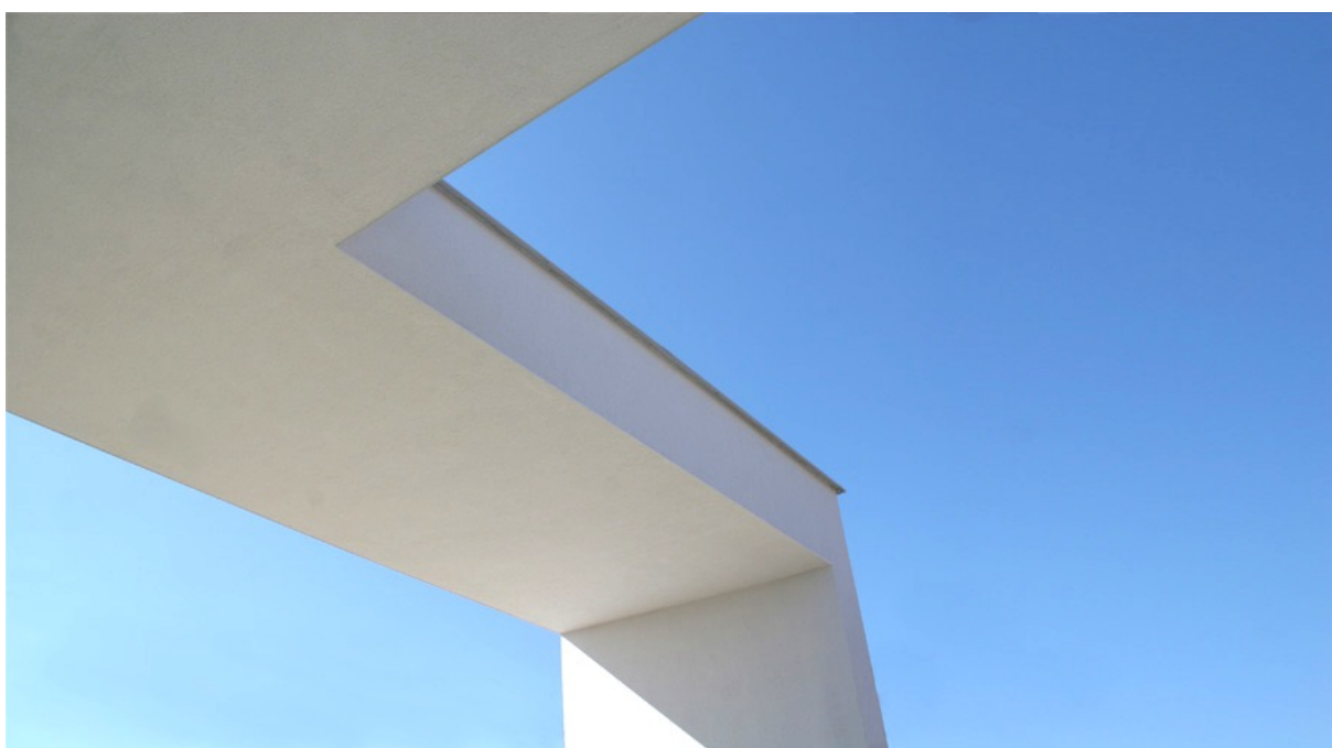
Az épületet körbeölelő fehér „szalag”
