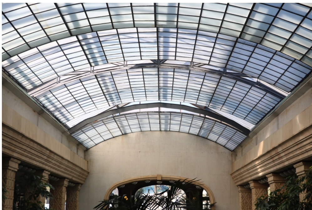
100. Rekonstruált üvegsztrások a pezsgőfürdő felújított felülvilágítóján (Szent Gellért fürdő)
