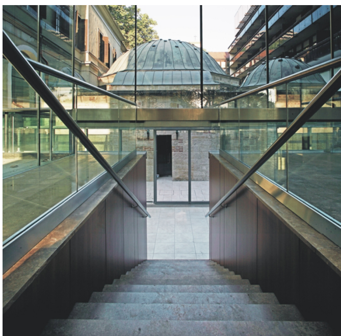
109. A Veli bej fürdő rekonstrukciós átépítése – lépcső a kávézó felől
