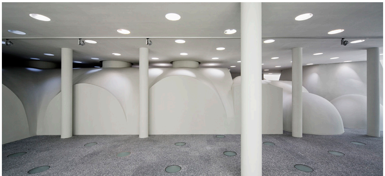
53. Rác-fürdő rekonstrukciós átépítése – újraépített zuhanycsarnok látszóbetonnak tervezett felülete – makettszerű megjelenés
