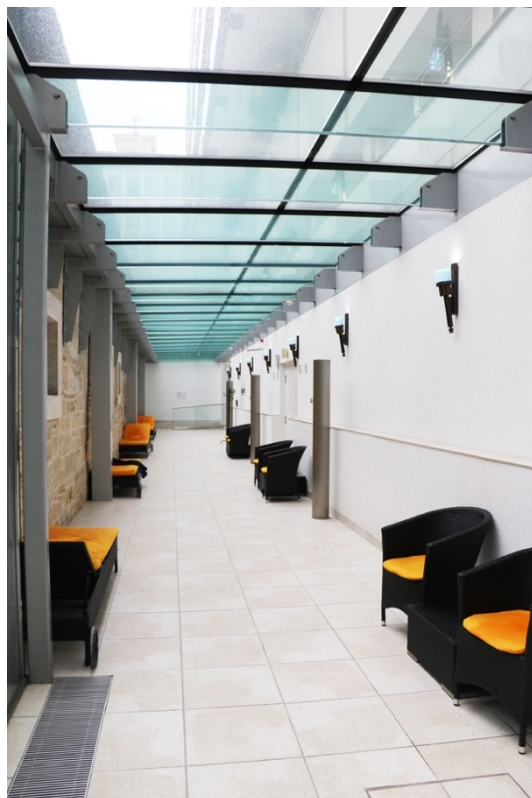
111. A Veli bej fürdő rekonstrukciós átépítése – az üvegezett tetejű közlekedő a török falak és a kórházzsármny között
