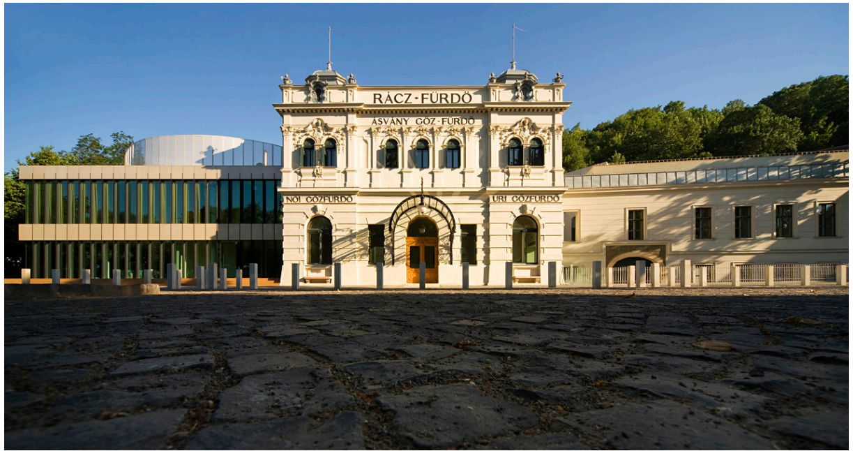
52. Rác-fürdő rekonstrukciós átépítése – főhomlokzat – régi és új határozottan elkülönül
