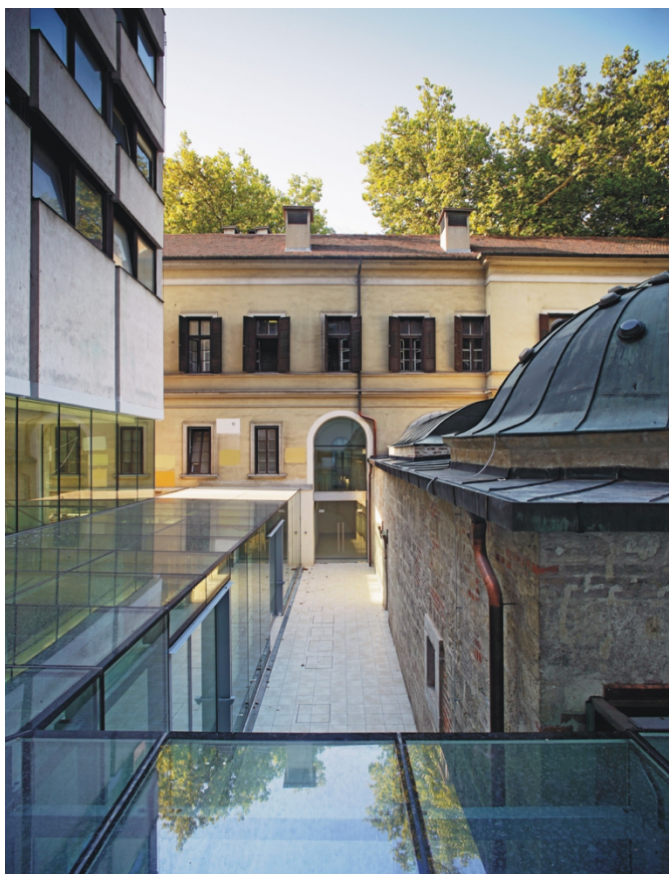
108. A Veli bej fürdő rekonstrukciós átépítése – korszakok találkozása
