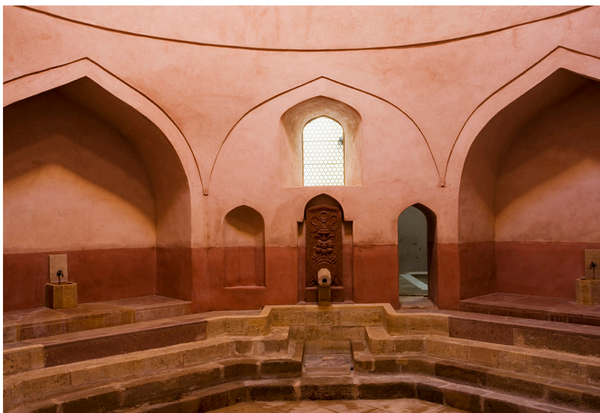
57. Rác-fürdő rekonstrukciós átépítése – a török fürdő rekonstrukciója
