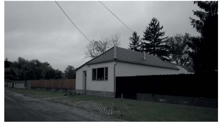
Utcai homlokzat képe a megközelítés irányából
