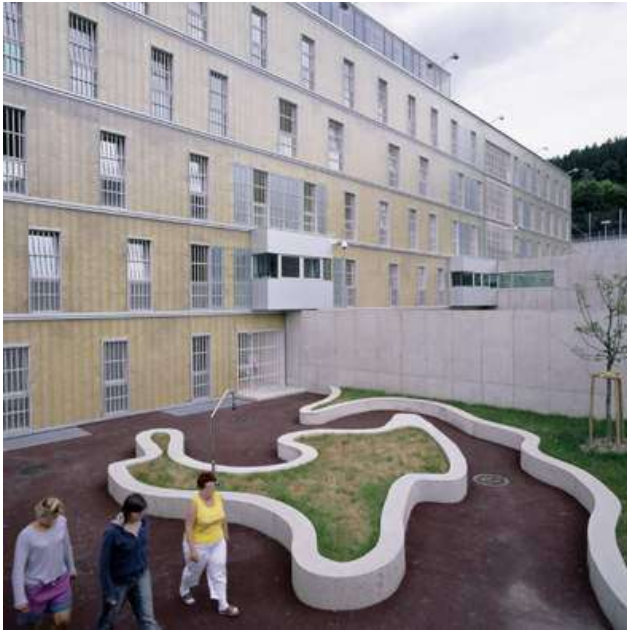
udvar a cellák homlokzatával
