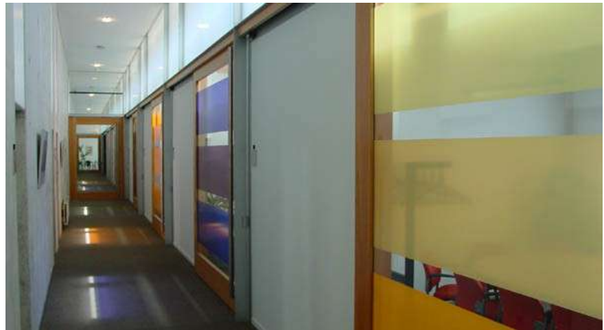
a középfolyosók sötétségének megszüntetésére tett építészeti megoldás: végifutó felülvilágító sáv
