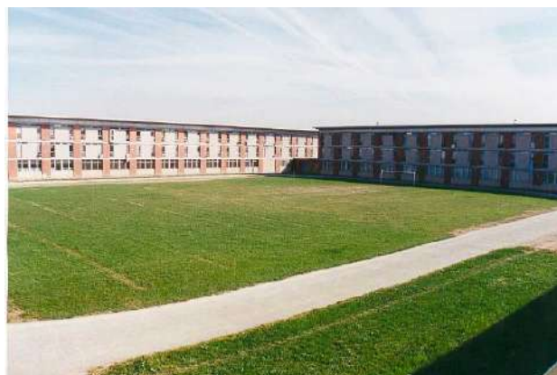
Franciaország, Muret börtön (1965) – Fotó: cd-muret.justice.fr
