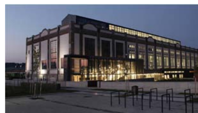
Revitalizált ózdi Erőmű, ma Kultúr-gyár építész és fotó: Mixa Stúdió
