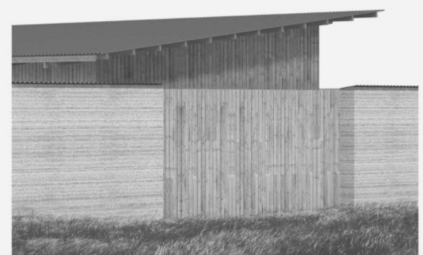
észak-keleti homlokzat részlet
