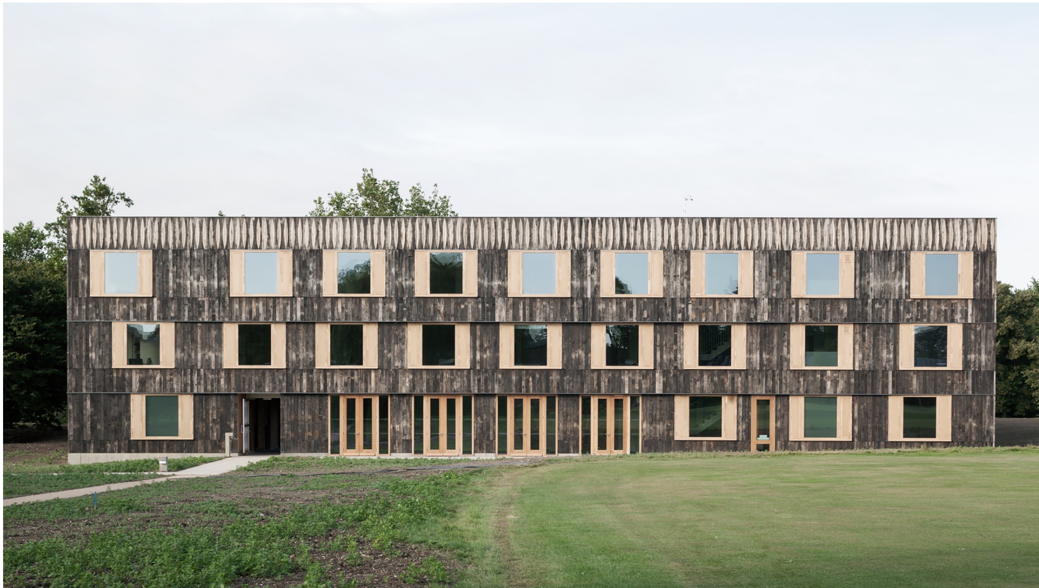
Cowan Court, kollégiumépület, Tom Emerson, 2016
