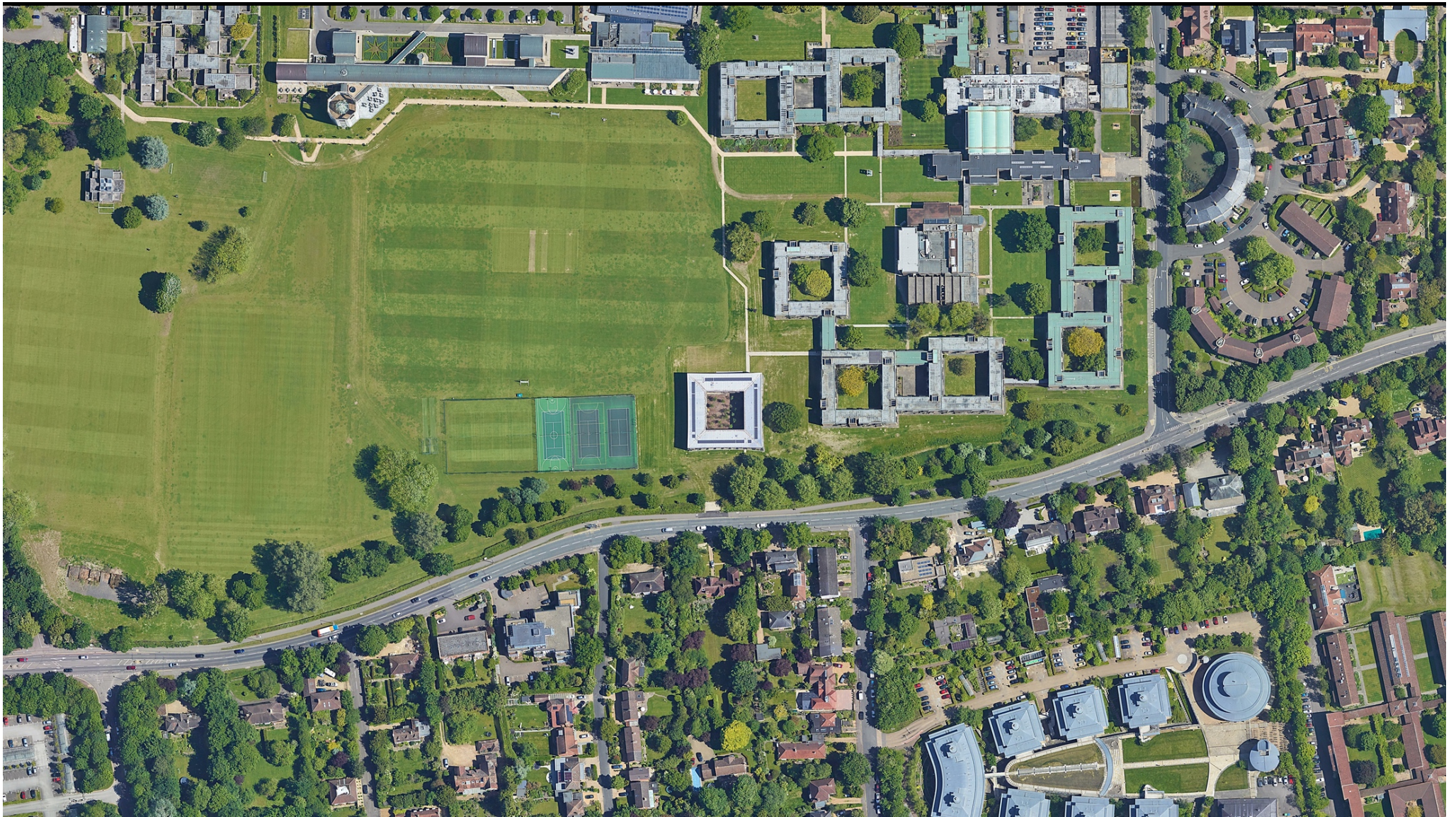
Cowan Court, kollégiumépület, Tom Emerson, 2016
