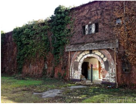
Komplex I. 2019 ősz..... TERMÉSZET ÉS ÉPÍTÉS ZET
