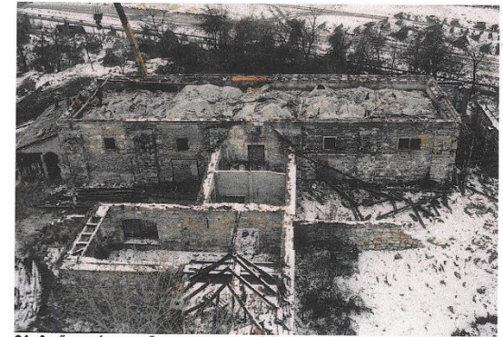
31. A LŐPORTÁR A TETŐSZERKEZET ELBONTÁSA UTÁN 1996. (ÉTELE KÖR 3045/B. SZABÓ KÁROLY)
