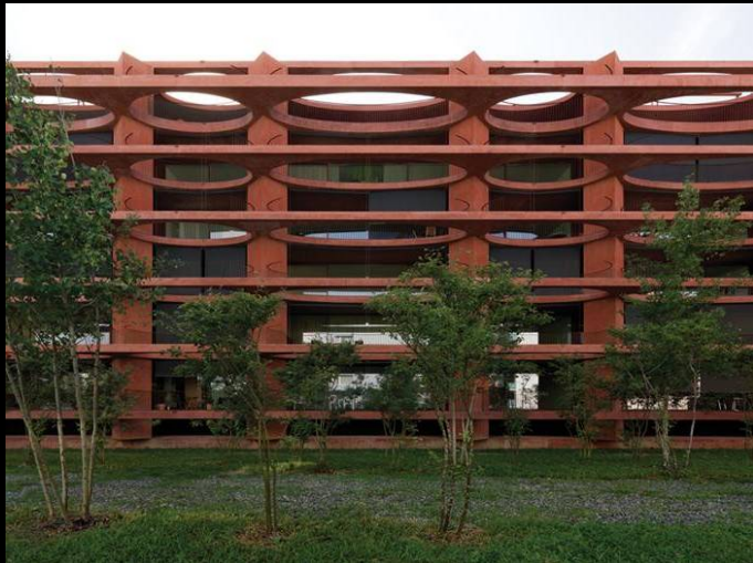
Olgiati, Valerio, Schleife apartmanház, Zug, 2008-2012
