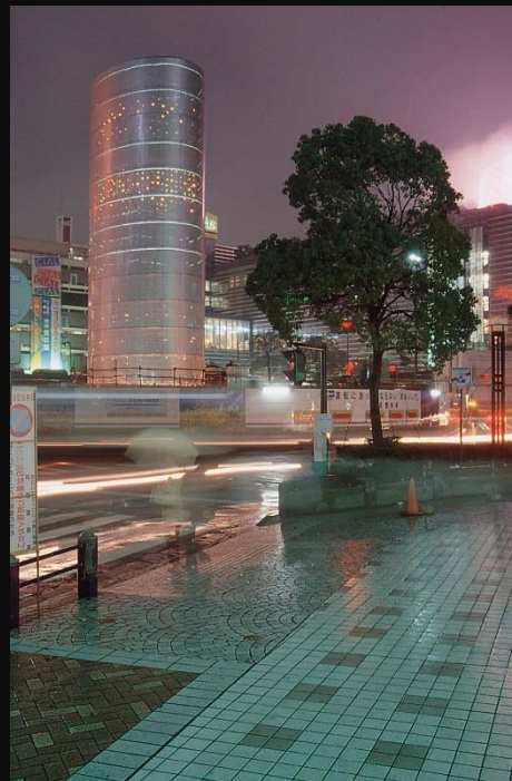
Toyo Ito, Szelek tornya, Yokohama, Japán, 1986 Meglévő vasbeton víztartály beburkolása, mely léghőszigetelő
