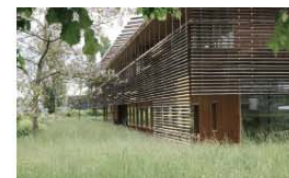
06 egészségügy, rehabilitációs központ Herzog&de Meuron Rehab központ Európa, Svájc 2002
