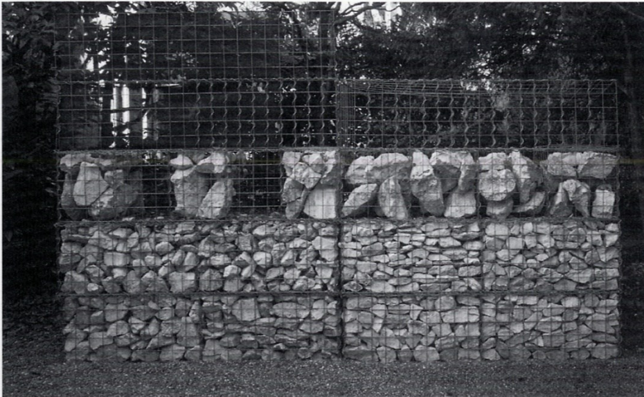
Erste Versuche mit Schanzkörben im Hof der Architekten. Initial mock-up with baskets in the architects' yard.
