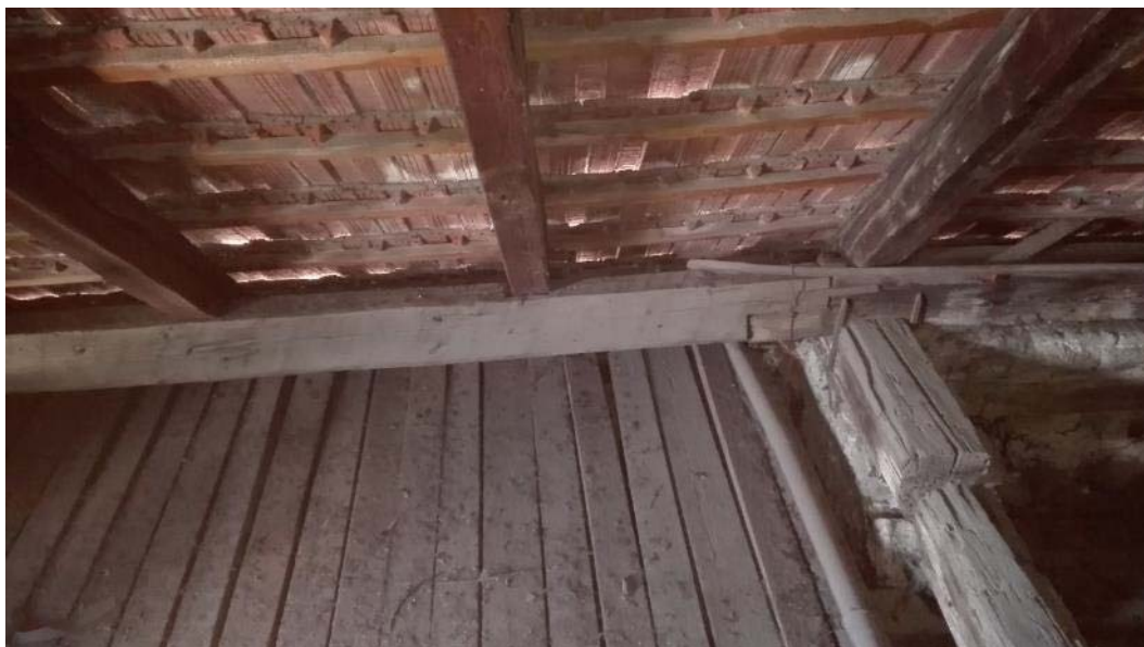
35. ábra A talpszelemen toldása a teraszbeépítés fölött (szemmel látható a lehajlás)
