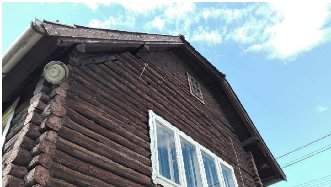
11. ábra Ideiglenesen rögzített fagerendák az épület DK-i homlokzatán (balesetveszélyes)
