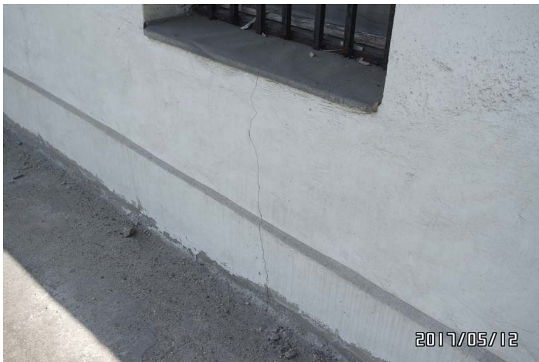
8. ábra Repedés az épület ÉK-i homlokzatán
