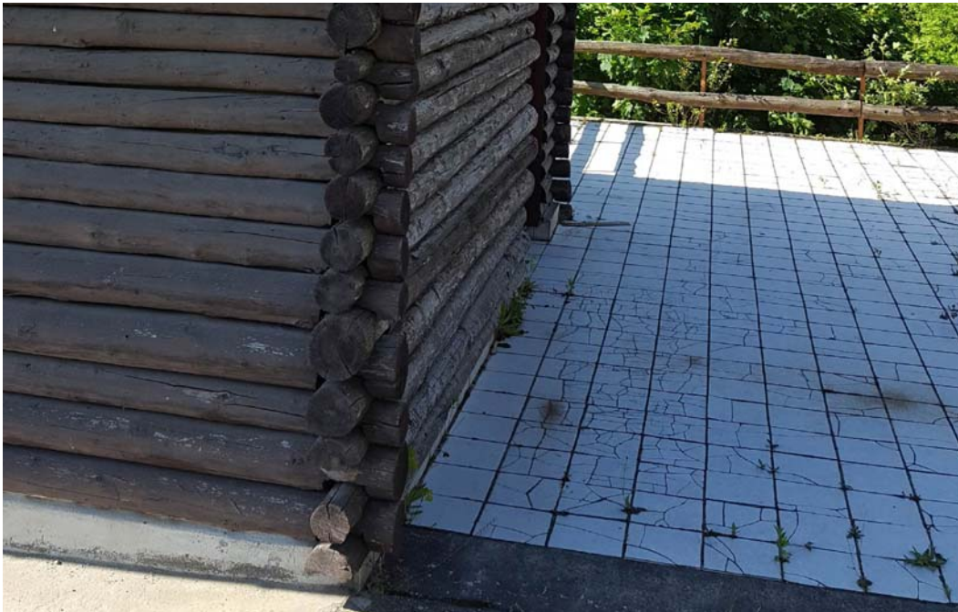
20. ábra Töredezett, szétfagyott teraszburkolat
