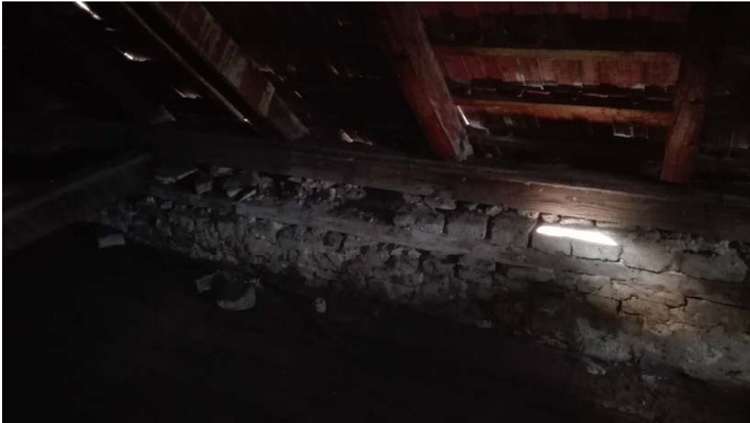
33. ábra A talpszelem alatti falazat tönkremenetele
