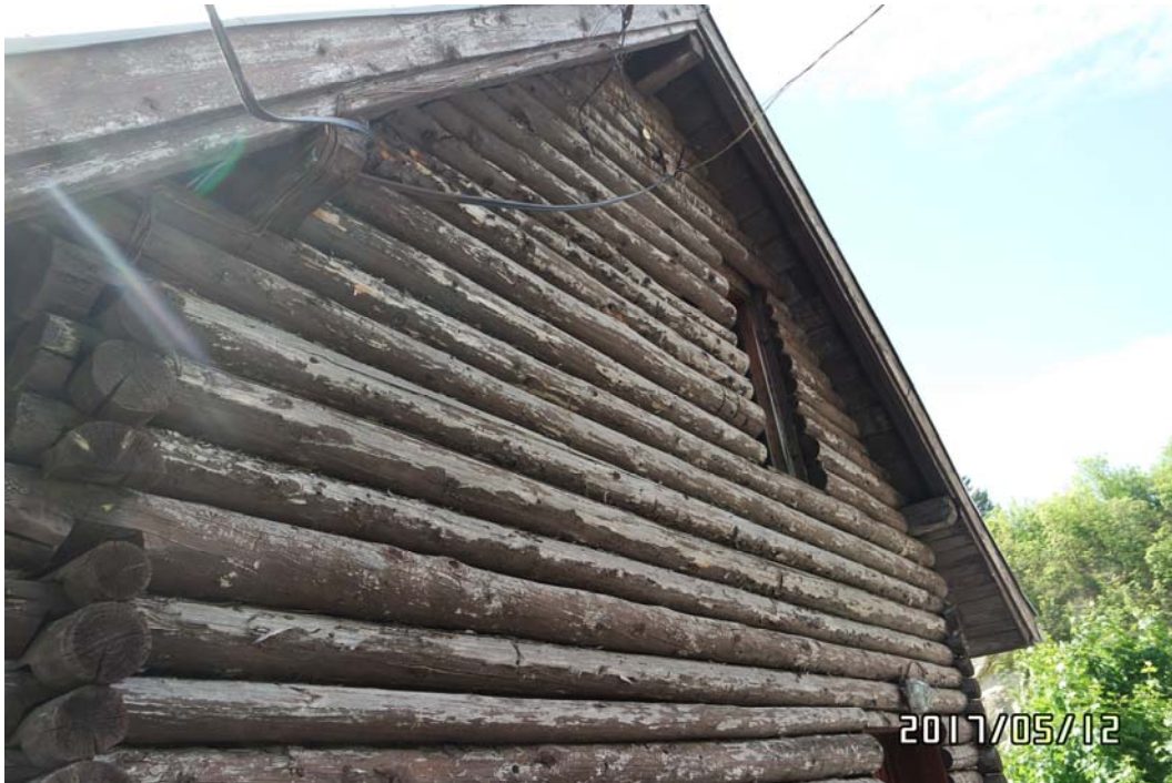
13. ábra Az épület ÉNY-i homlokzatán
