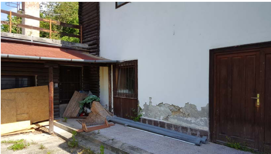
16. ábra Károsodás az épület DNY-i homlokzatán
