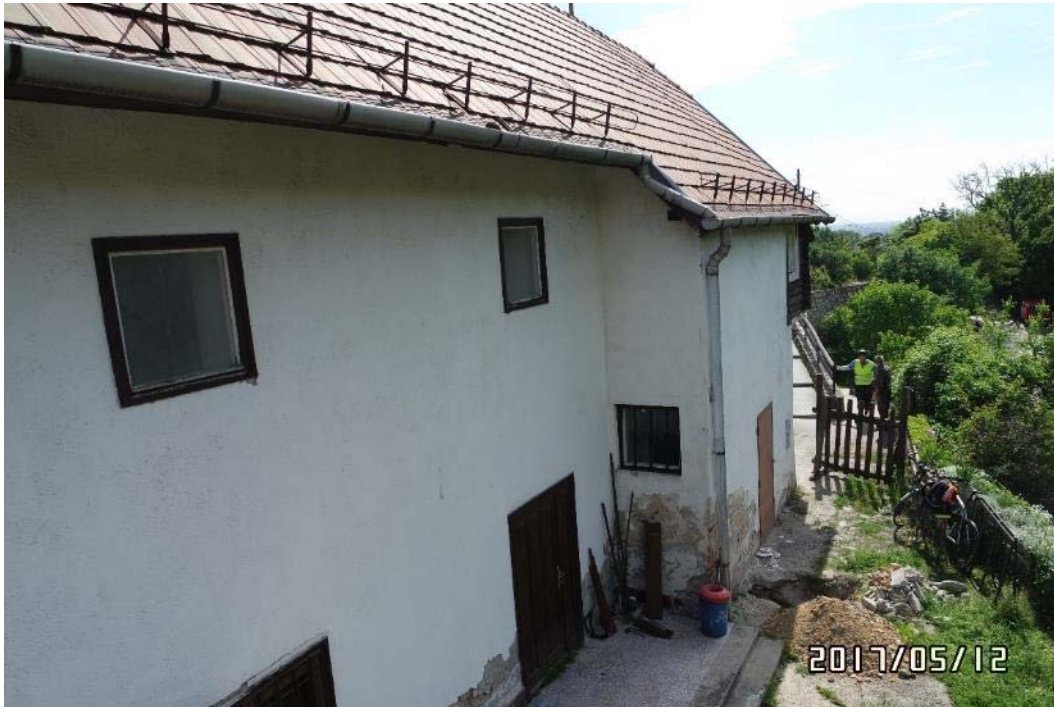
15. ábra Az épület DNY-i homlokzata
