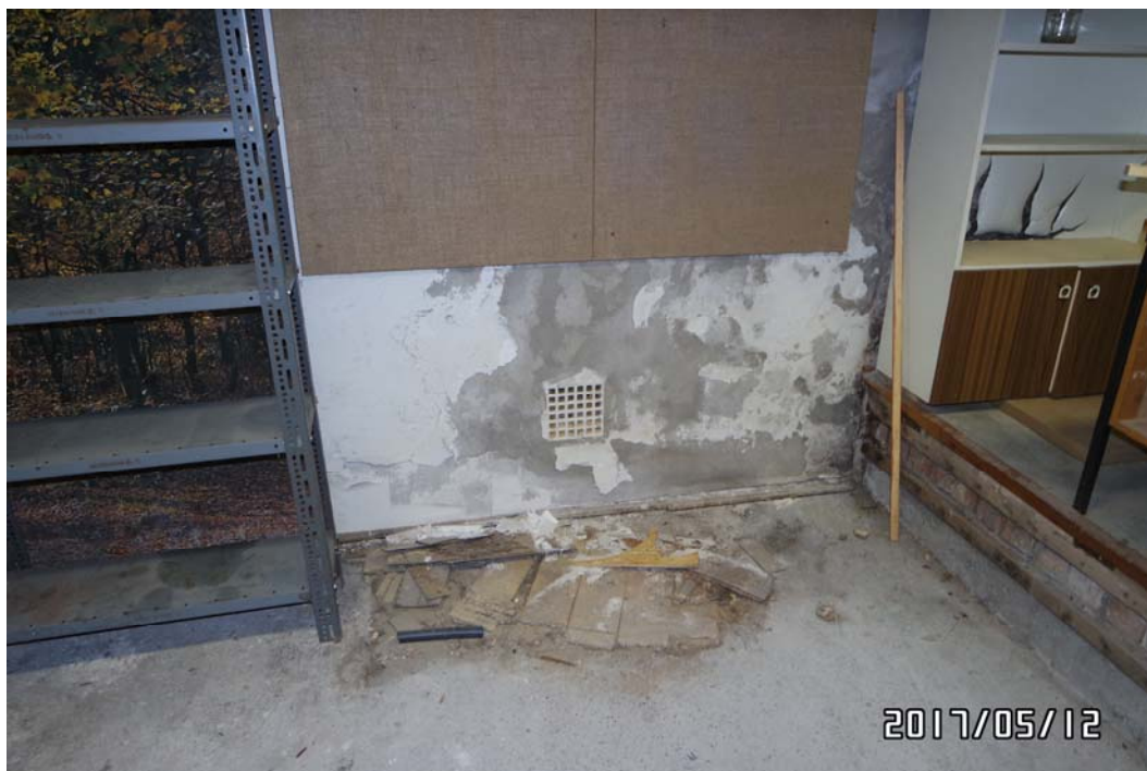
18. ábra Előtétfal károsodás a nedvesség hatására
