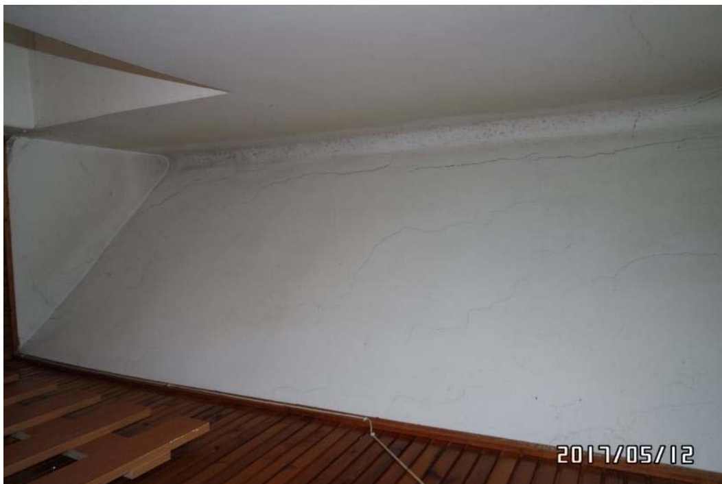
27. ábra Lépcsőlejáró feletti hálós repedések
