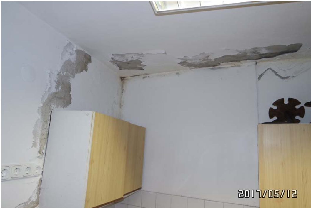
22. ábra Terasz szigetelési károsodása miatti beázás
