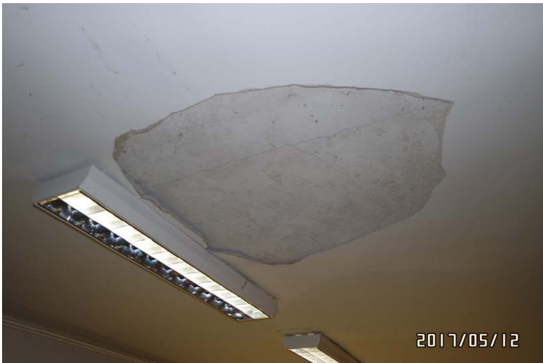
26. ábra Az alagsor feletti födém vakolatleválása
