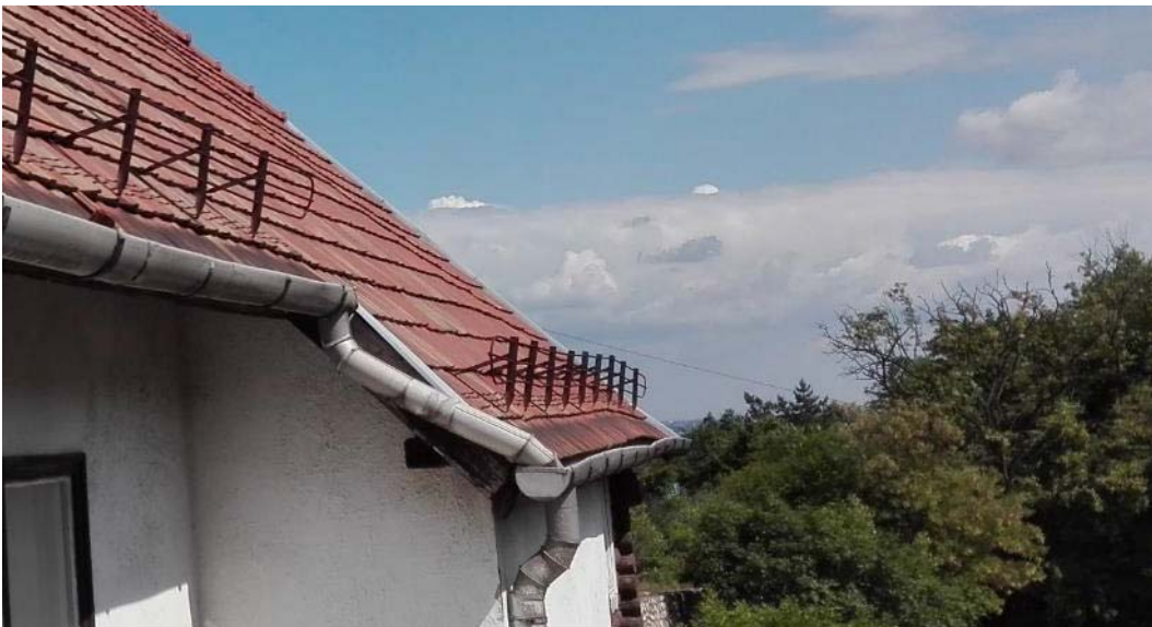
34. ábra A tetőszerkezet lehajlása az épület déli sarkánál
