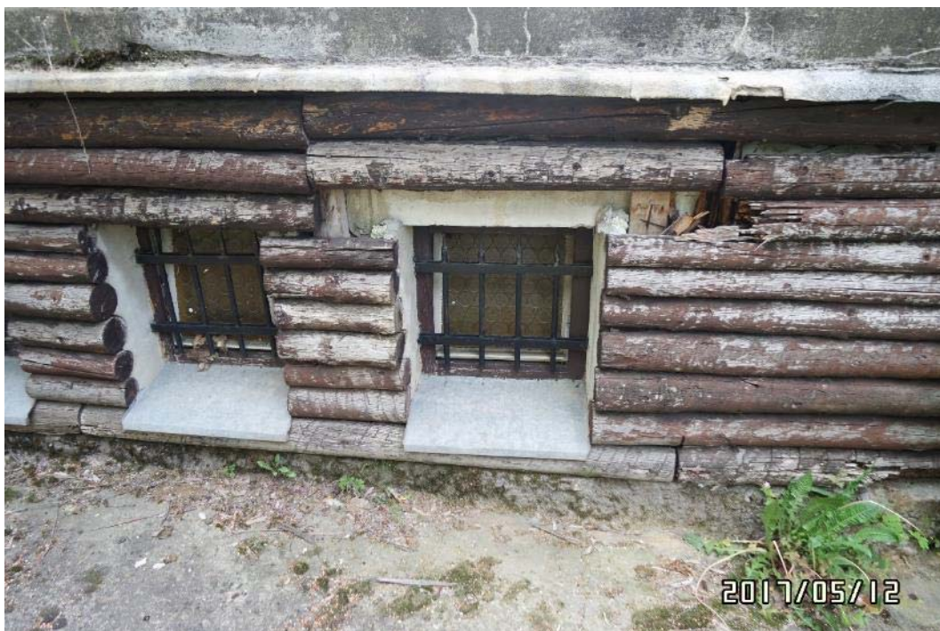
14. ábra Faborítás károsodása az épület ÉNY-i homlokzatán
