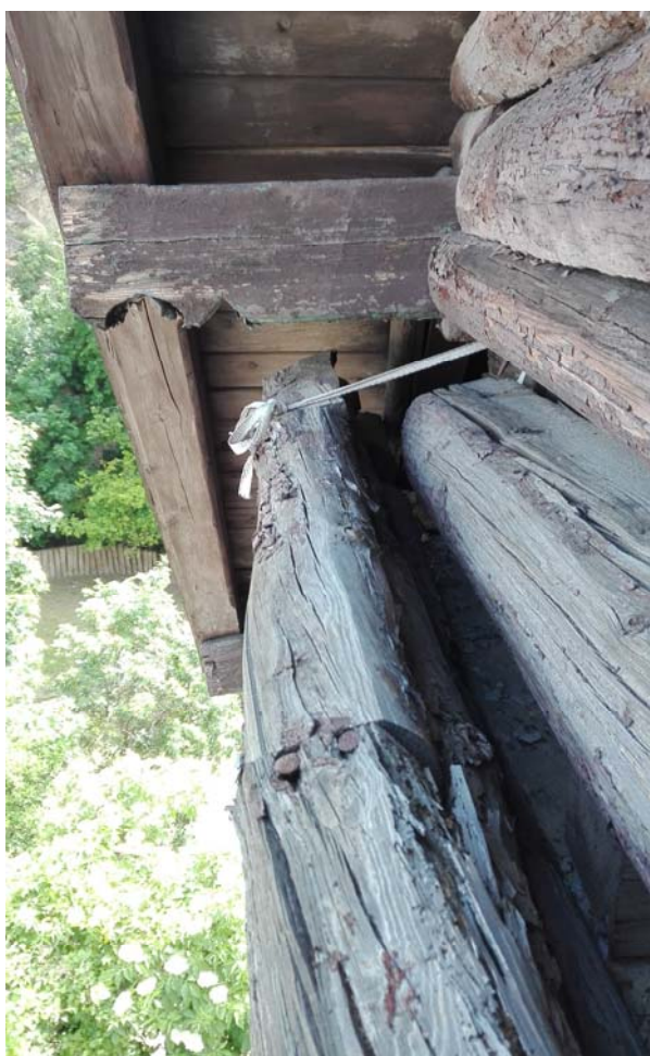
12. ábra Ideiglenesen rögzített fagerendák az épület DK-i homlokzatán (balesetveszélyes)
