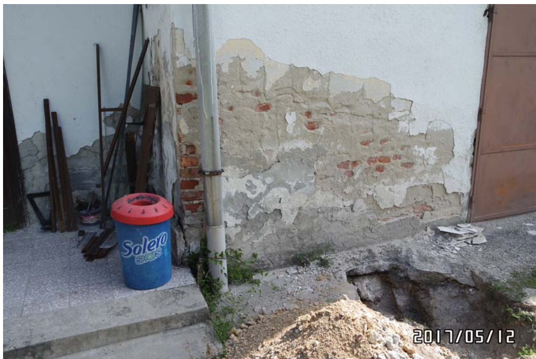
17. ábra Károsodás az épület DNY-i homlokzatán, az ereszcsonornánál
