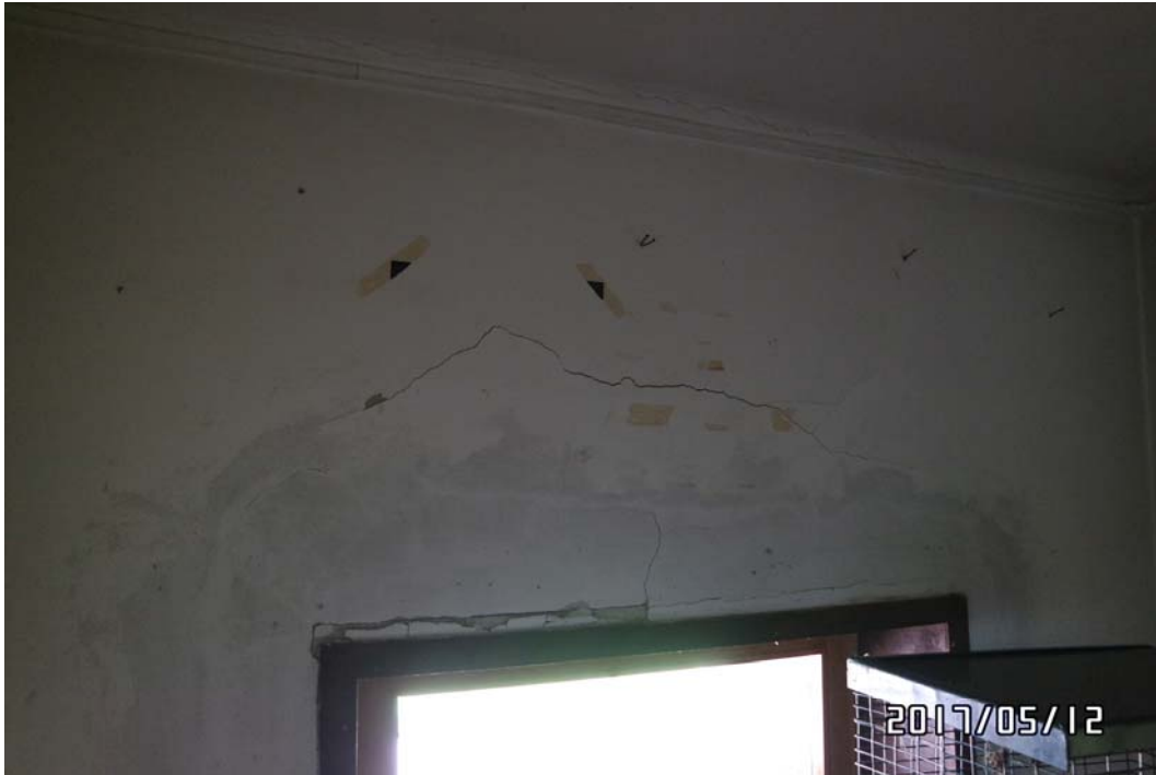
29. ábra Áthidalók károsodása
