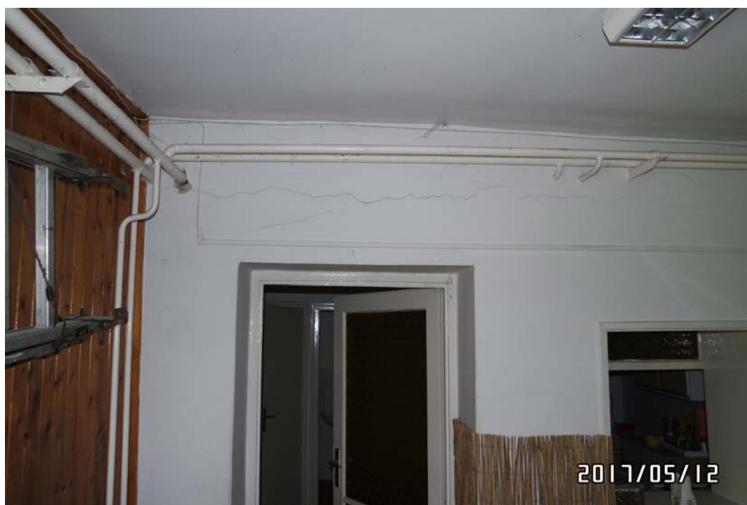
28. ábra Vízszintes repedések a teraszos rész csatlakozásánál
