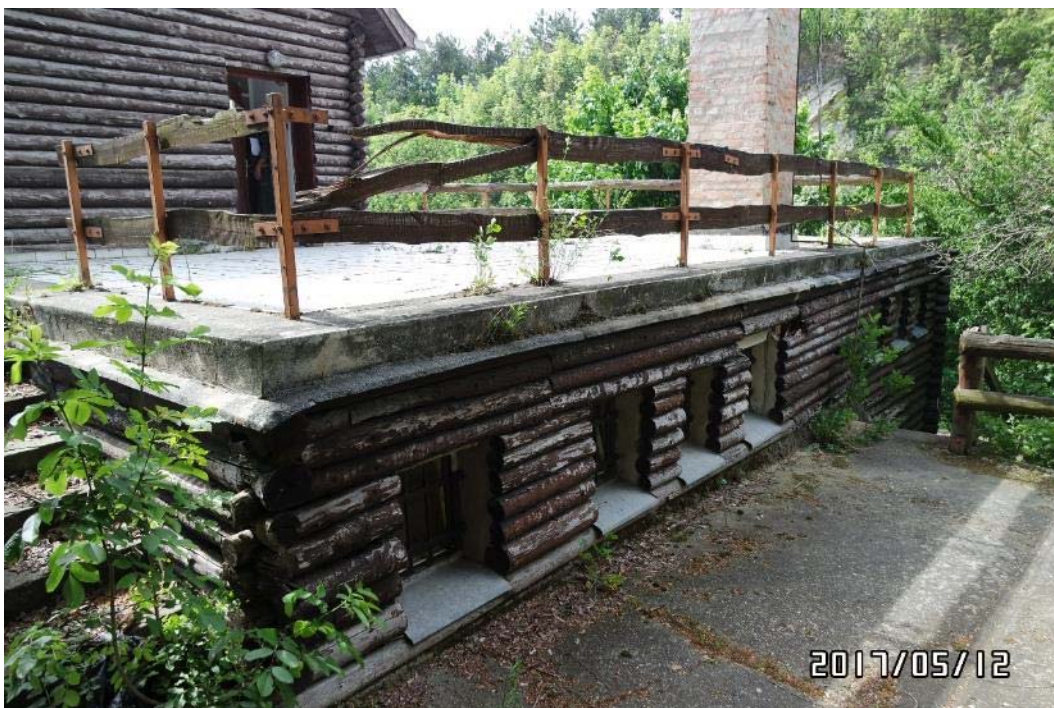
21. ábra Terasz károsodott korlátja
