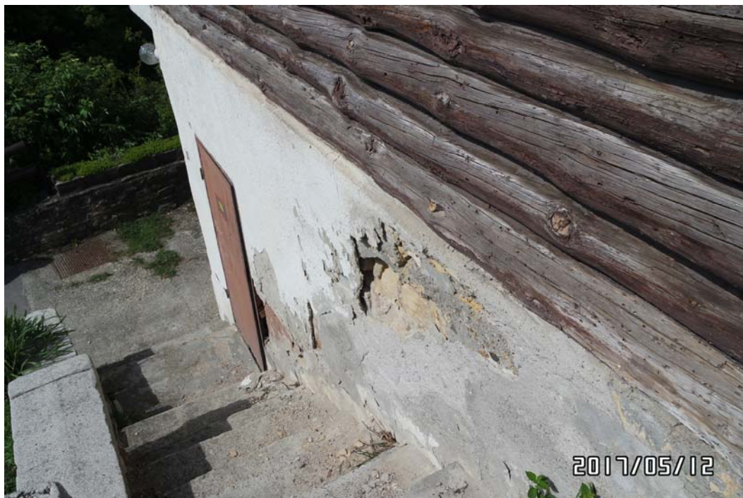
10. ábra Károsodás az épület DK-i homlokzatán
