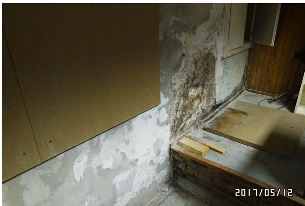
19. ábra Előtétfal károsodása, penészedés
