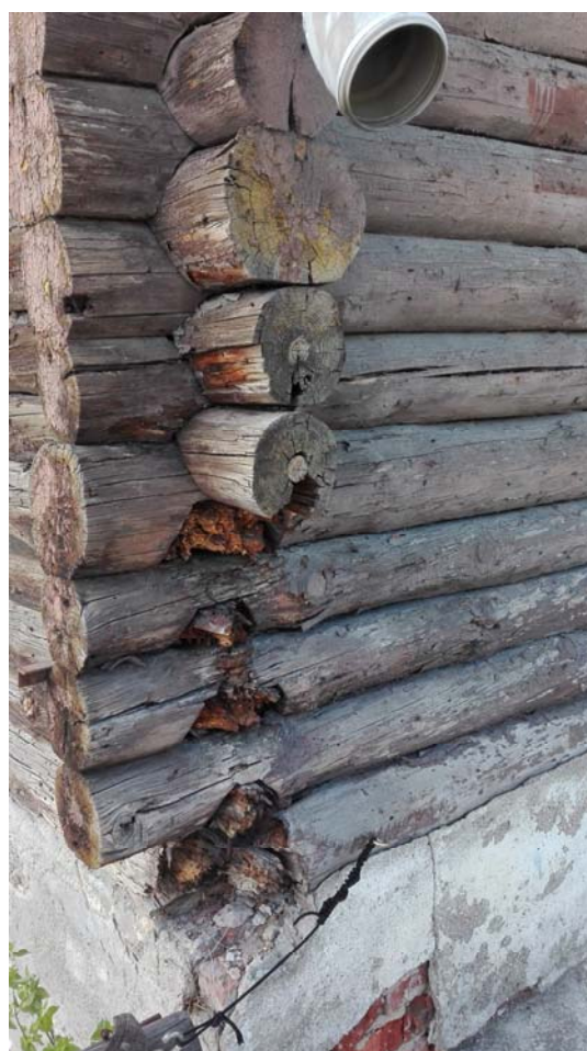
9. ábra Károsodott sarok az épület ÉK-i homlokzatán
