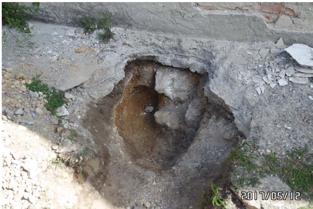
6. ábra Alapfeltárás az épület DNY-i homlokzatán
