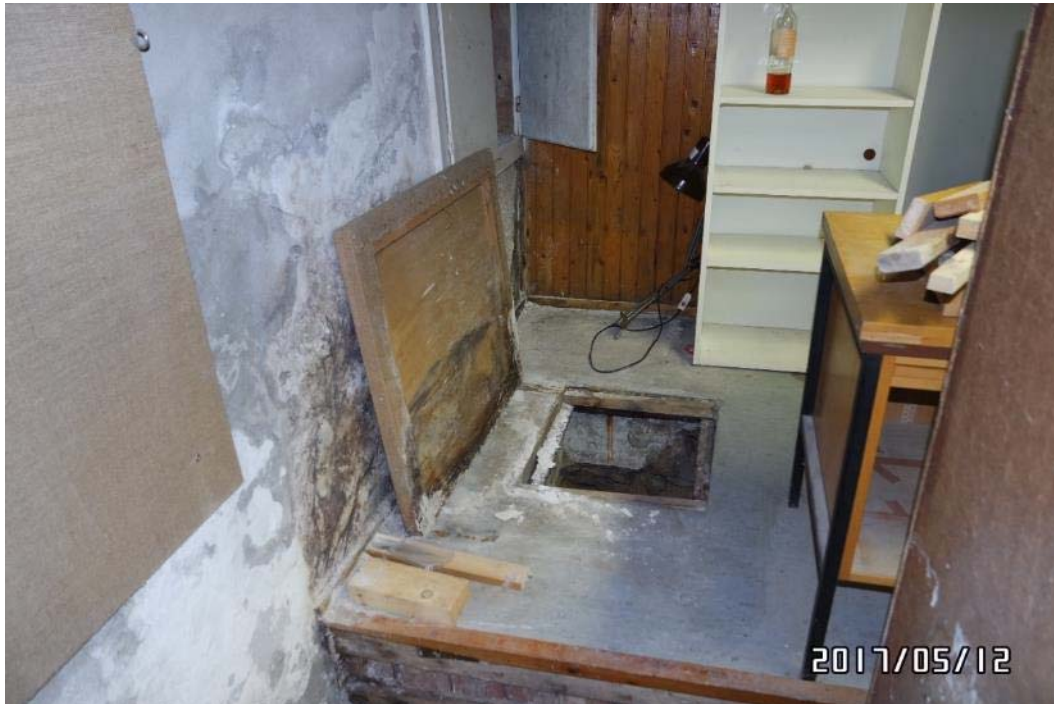
24. ábra Az épület alatti barlang bejárata az alagsorból
