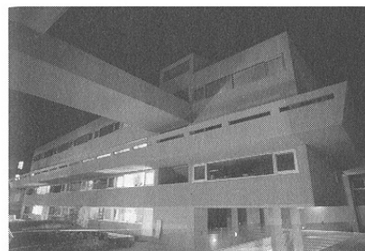
Belső udvari homlokzatok, passzázsok fotók: Hertha Hurnaus Photos of the courtyards, passageways
