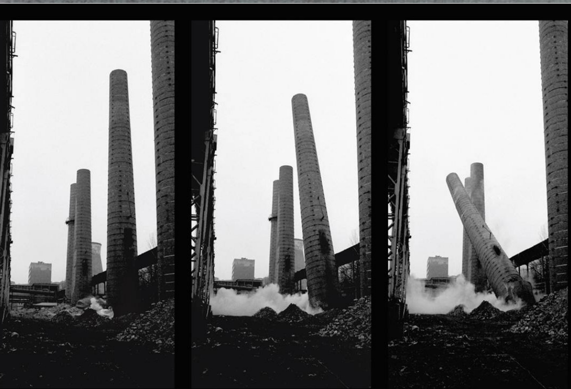
Az ózdi kémények felrobbantása, 2001-ben
